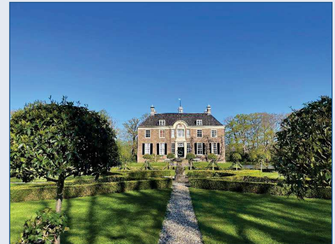
Ook in 2021: begeleiding van de uitvoering van het onderhoud, o.a. bij Huis den Berg
